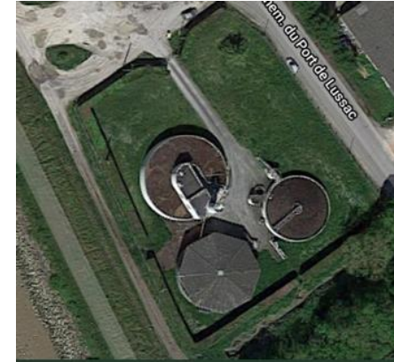
Station d'épuration de Blaye
