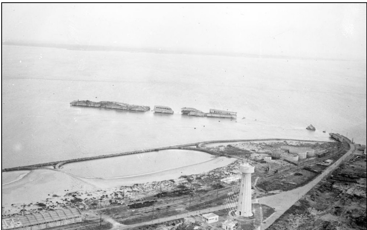
Figure 2.22 : Le môle du Verdon après sa destruction par des bombardements alliés en avril 1945 (source https://www.sudouest.fr/gironde/le-verdon-sur-mer/le-port-du-verdon-en-gironde-en-images-70-ans-d-histoire-17201029.php ).
