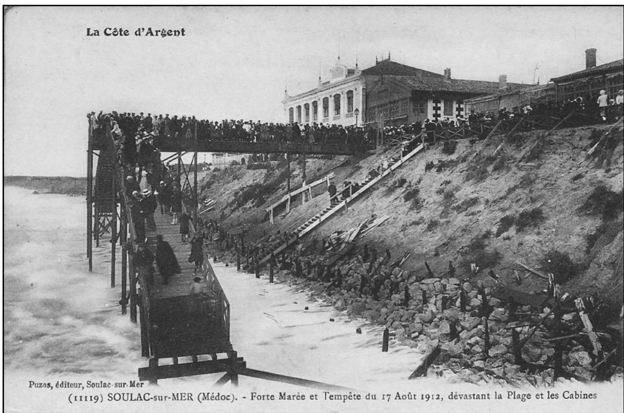
Figure 5.5 : Les cabines et la plage de Soulac-sur-Mer dévastées par une tempête en 1912.
